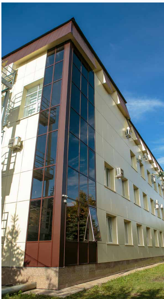
Облицовка фасада административного здания НГДУ «Бавлынефть», устройство кровли, установка доски почета
